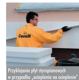
Uzupelnianie kleju w przypadku klawiszowania płyt
