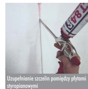
Uzupelnianie kleju w przypadku klawiszowania płyt
